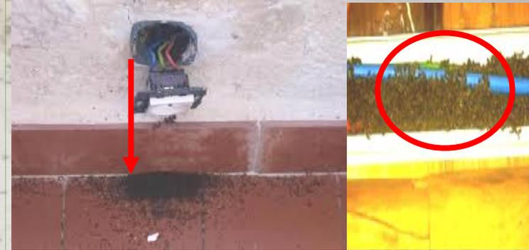
Les fourmis invasives détériorent les installations d'irrigations, les câblages téléphoniques et les installations électriques provoquant des courts-circuits.
